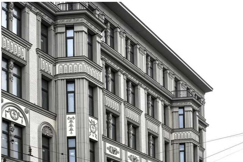
Рис. 3. Фасад здания из фибробетона
