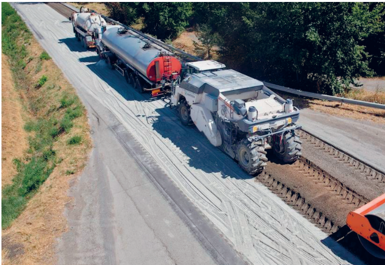
Рис. 3. Укрепление грунтов с помощью холодного ресайклинга
