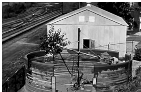
Рис. 1. Уильям Урошель демонстрирует свою машину для возведения стен. Вальпарисо, штат Индиана
