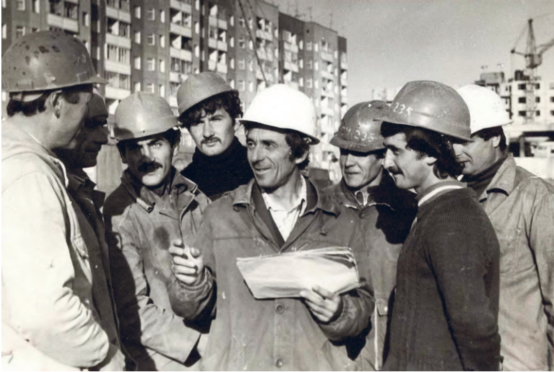
Рис. 1. Комплексная бригада по капитальному строительству СУ-235 стройтреста № 37 Лавренчука Д. Ф.
